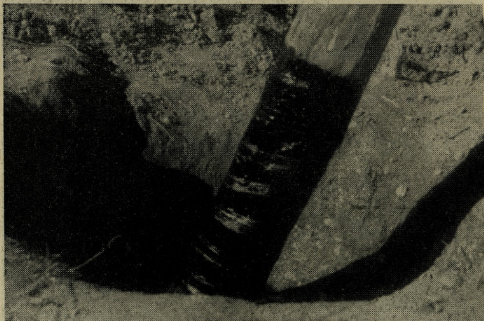
Končno premažemo bandažo z bitumenom
