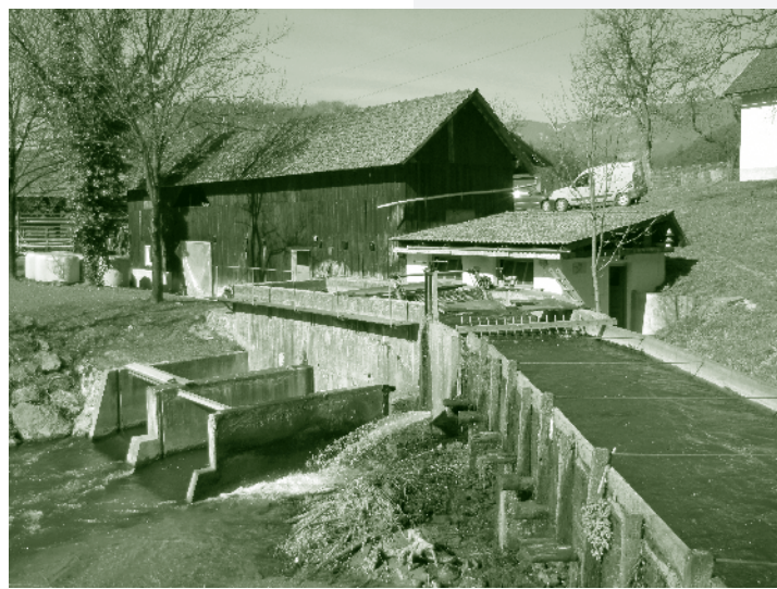
Slika 3: Čistilni rešetki, posedalni kanal in izliv iz turbin
