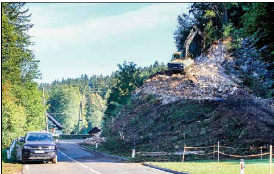
Ker je teren skalnat, je potrebno veliko razbijanja, vrtanja in miniranja.
