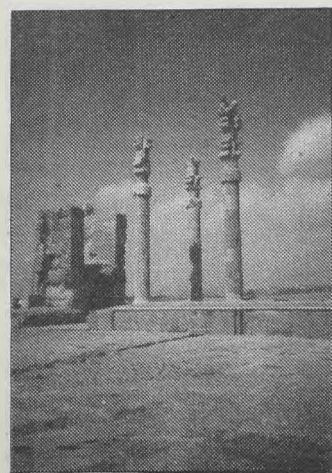
Veliki stebri so nosili lahke grede iz cedrovega lesa – Persepolis
