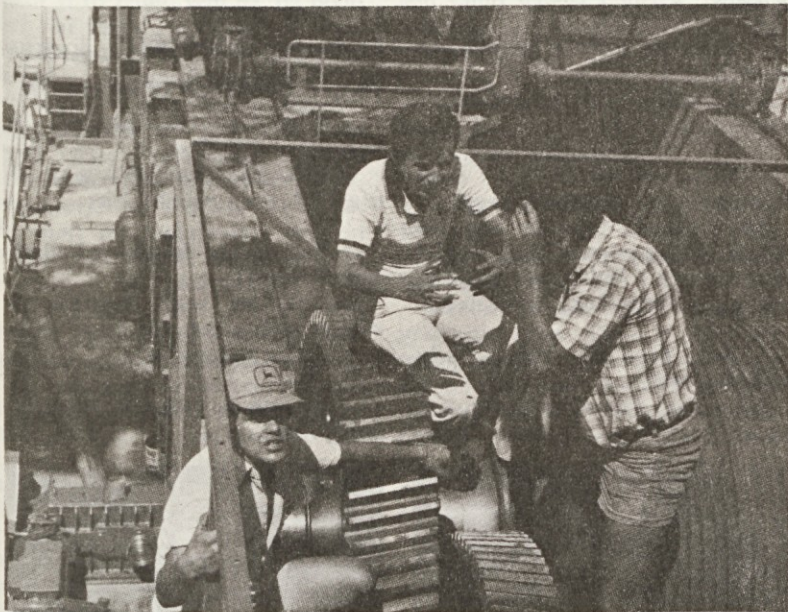
Boben glavnega dviga je na svojem mestu. Nadzornik montaže razlaga delovanje žerjava bodočim upravljalcem.
