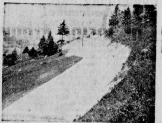
Gradnja ceste Lipovšica—Nova Štifa (zemeljsko delo)
