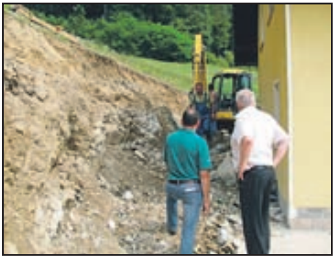
Med odstranjevanjem naplavin pri Celcerju
