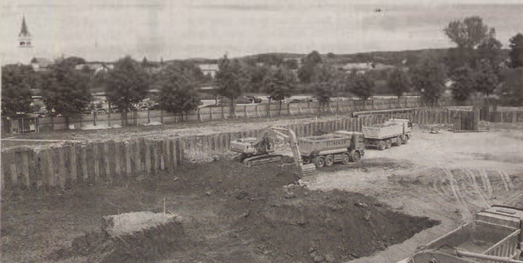
Še kakih deset dni bodo potekala zemeljska dela; izkopano zemljo vozijo v okolico na deponije, interesenti pa jo lahko tudi dobijo, če se oglašijo pri izvajalcu.
