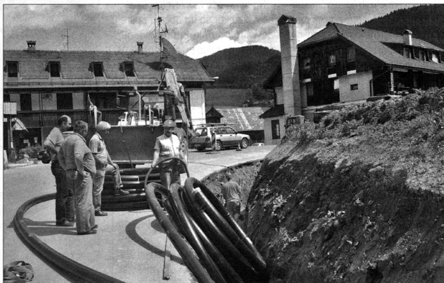
V Lučah so začeli z izkopom in polaganjem vodov (foto: Marija Lebar)
