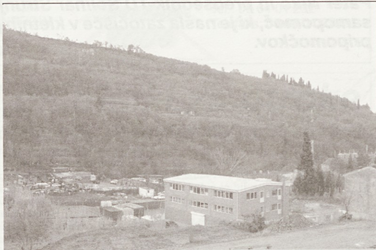
Skladišča hala podjetja Hartis še vedno brez komunalne infrastrukture. V ozadju odpad, na katerega bodo imeli pogled tamkajšnji novi stanovalci.
