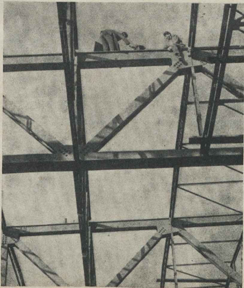
Montaža I. — (Foto O. Dolenc)
