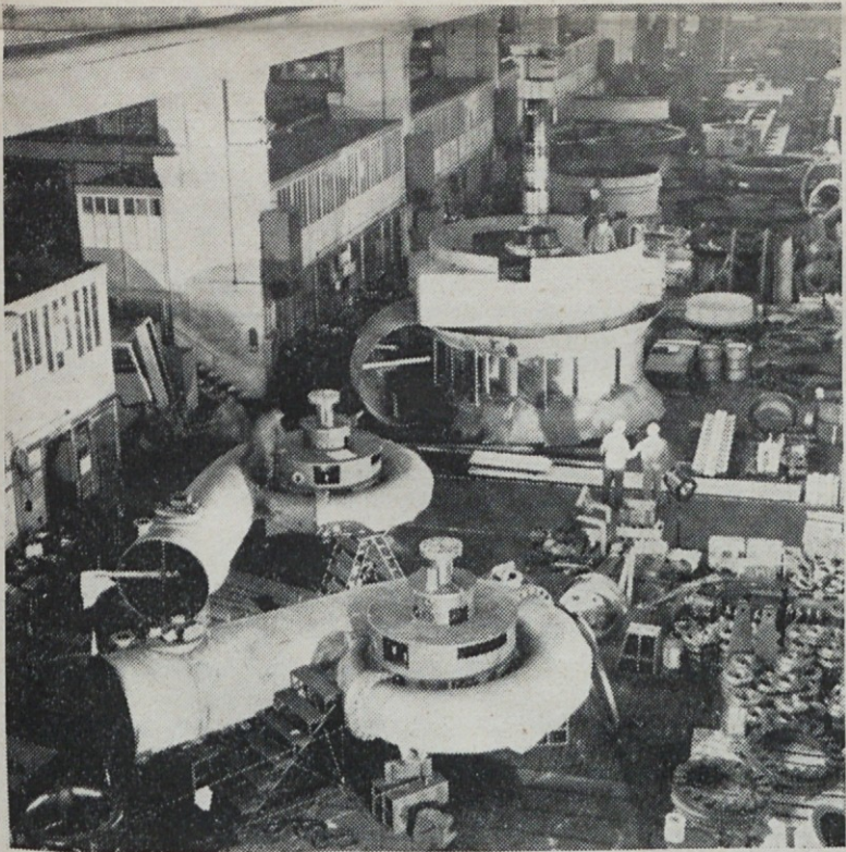
Pogled na poskusno montažo turbin za HE Kalimanci (v ospredju) in za HE Potpeč (zadaj)
