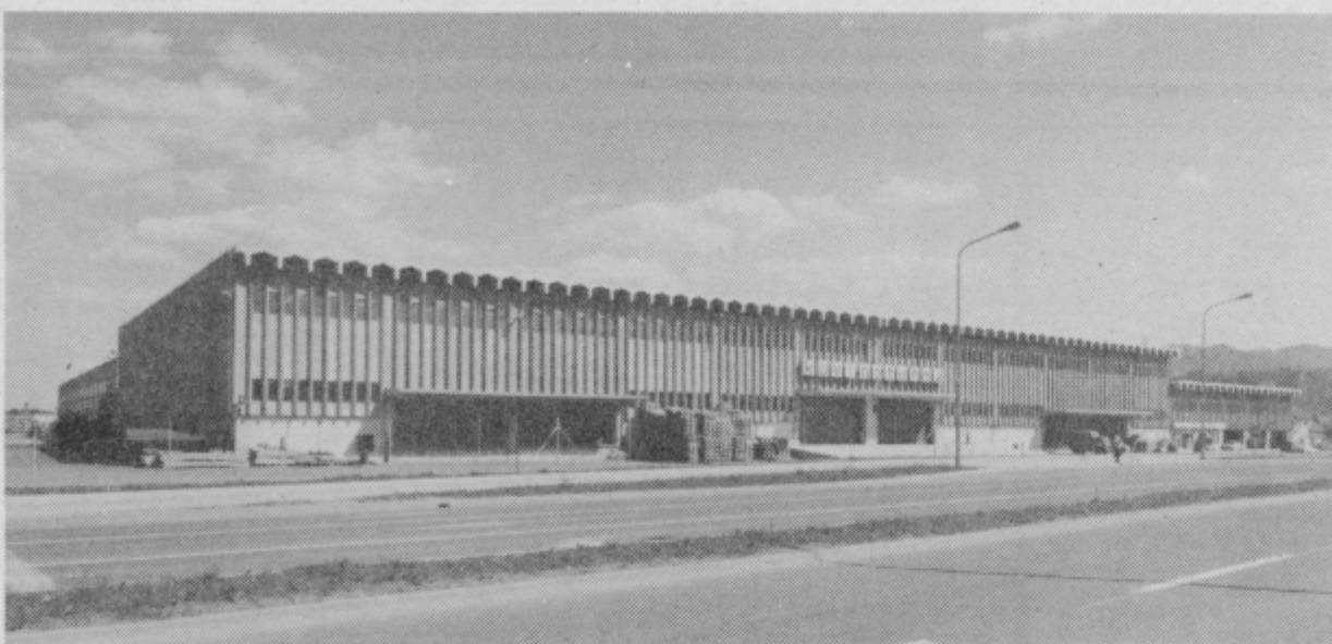
Med objekti, s katerimi se Gradisov tozd Gradbena enota Celje lahko ponaša, je tudi sodobno skladišče Kovinotehne na Hudinji v Celju. Podobnih objektov je Gradis zgradil na celjskem območju še nekaj.
