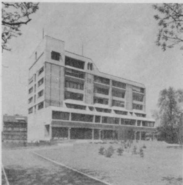
V središču Celja je Gradis pred kratkim zgradil sodobno poslovno zgradbo, ki se zanimivo spaja s svojo okolico.
