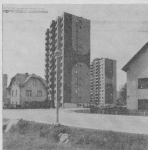
V Novi vasi v Celju so pred kratkim zrasli stanovanjski stolpiči, ki jih je zgradil Gradisov tozd iz Celja.
