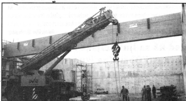
Montaža prečnih nosilcev s 25-tonskim avtodvigalom (foto: Cirl Sem)
