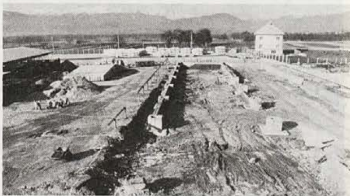
Novogradnja: temelji za podaljšek obrata plastike
