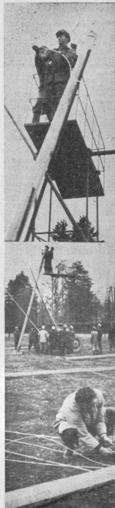
Zgoraj: delo ekipe s posebno izdelanimi mostički za postavljanje težkih betonskih opornikov. Spodaj: inž. Pelikan poučuje delavca, kako mora montirati vezi na oporni drog.
