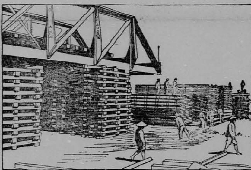
Gradnja mostu v Mandžuru.
