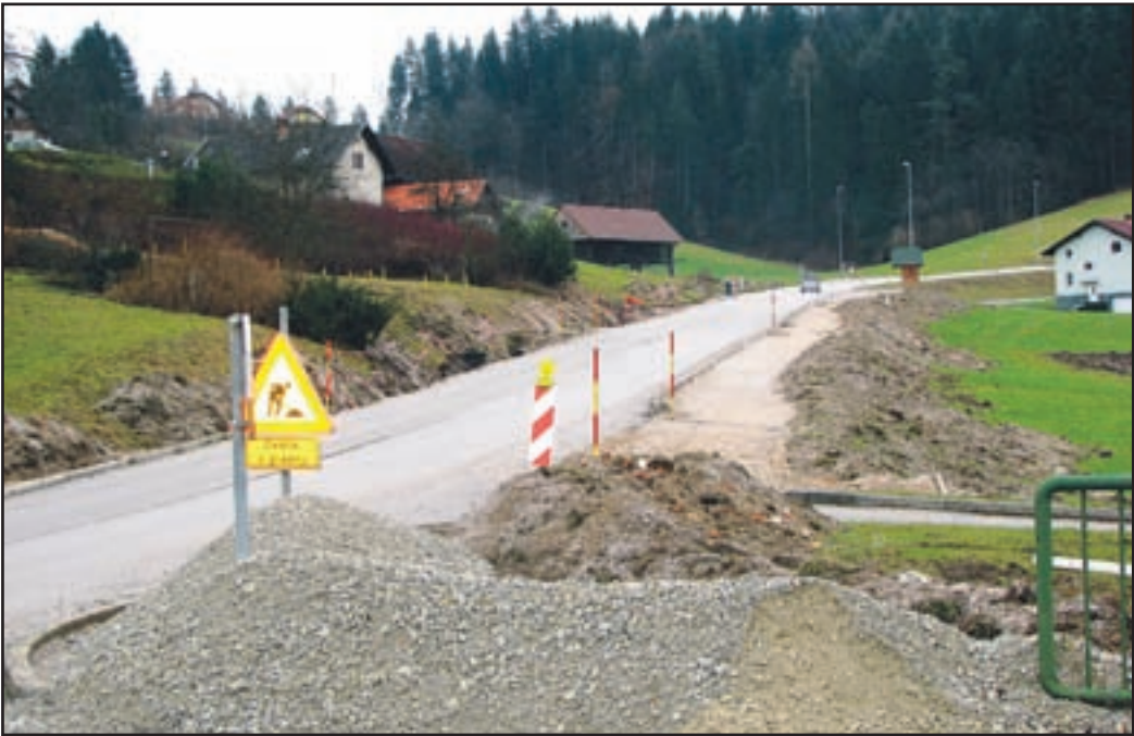
Lani so zgradili kanalizacijsko omrežje od trgovine v središču kraja do križišča proti Lajšam in nanj priključili 17 stanovanjskih enot.
