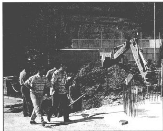
Nova kotlovnica bo velika ekološka in tehnološka pridobitev.
