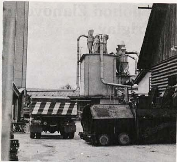
Polaganje asfalta pred zabojarno
