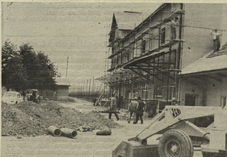
Na gospodarskem dvorišču kmetijstva II v Šempetru so uredili fasade, napuše, obnovili menzo; sedaj pa obnavljajo kanalizacijo, za tem pa bodo asfaltirali celo dvorišče
