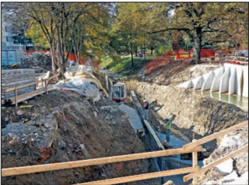
Promenada. Gradnja novega mostu.
