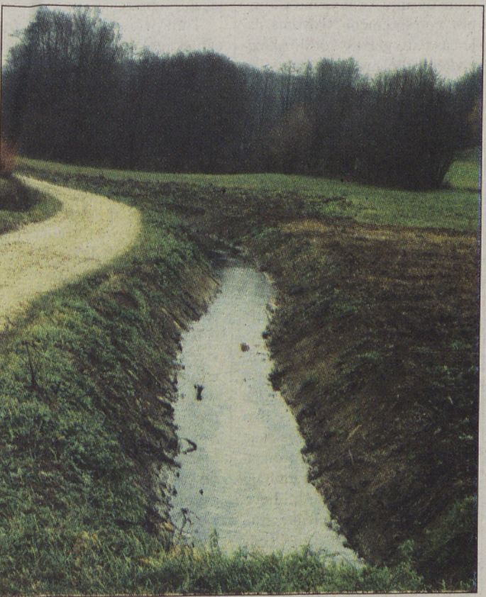
Ureditev potoka v Okoslavcih, ki je v preteklosti povzročal zaradi poplavljanja precej preglastic, pomeni veliko pridobitev za celotno KS Kapela. Foto: M. JERŠE
