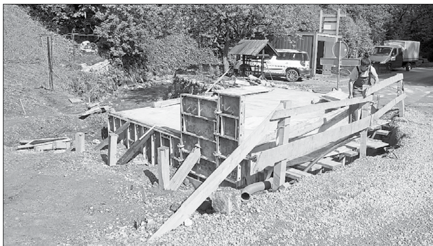
Gradnja novega mostu, ki močno izboljšuje poplavno varnost v naselju. (Foto: ML)
