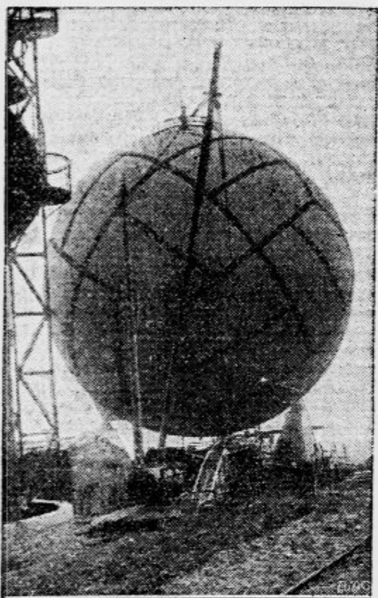
so zgradili v znanem kopališču Ostendu
