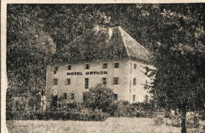
Pogled na hotel v Ortneku
