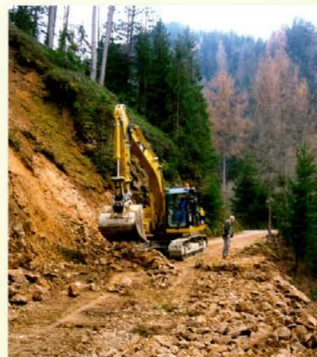
Sanacija gozdne ceste Črna–Najevska lipa
