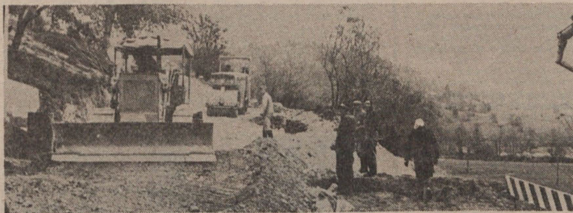
Komunalno podjetje Vič je glavni izvajalec rekonstrukcijskih del na cesti na Rob. Omenjeno cesto rekonstruirajo v etapah. Najzahtevnejši odcep ceste obnavljajo prav sedaj in sicer od odcepa ceste v Kočevje mimo naselja Raščica. Sredstva za ta odsek so v višini četrte vseh sredstev, ki znašajo 700.000 din prispevali občani, ostalo pa občinska skupščina. (Foto: F. Modic)
