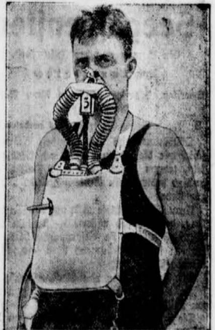
hat ein amerikanischer Seeoffizier einen Apparat konstruiert, der der eingeschlossenen Besatzung ermöglichen soll, das Boot zu verlassen und an die Wasseroberfläche zu gelangen. Er wurde der Apparat in Tiefsen bis zu 100 Metern erfolgreich ausprobiert.
