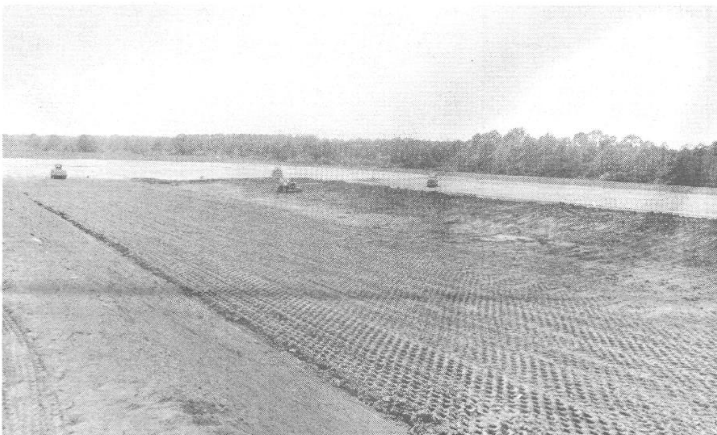
Delo na zaščiti tretjega polja deponije so v teku. Naravni tesnilni slog pred polaganjem je že položen, v teku pa so priprave na polaganje umetnega tesnilnega sloja – folije.
