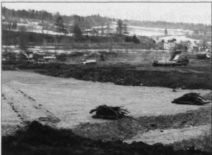
Gradbišče HE Blanca
