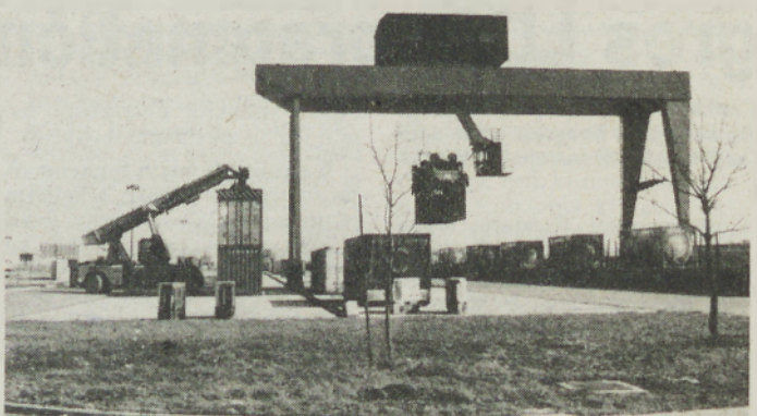
Kontejnerski terminali Ljubljana so opremljeni z viličarji, manipulatorji in portalnim dvigalom, s katerimi lahko dvignejo tovor težak od 12 do 40 ton. Foto: bbp
