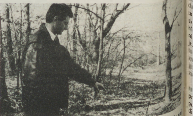
BO DOLGOLETNA ŽELJA POSTALA RESNIČNOST? »Ta bi po projektu izgradnje glavnega voda vaškega vodovoda od Moravskih Toplic do Bogojine stal vodni hram, namenjen za siranje vode,« je povedal predsednik gradbenega odbora ANTON CASAR.
