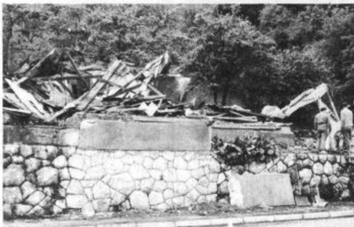
Sporne in nevarne ruševine ob Partizanski cesti ni več, saj je občina Velenje poskrbela za odstranitev in popravilo krivice Jusipovičev.
