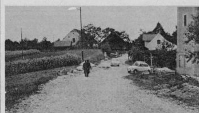
Makadamska cesta proti Majšperku kliče po asfaltni prevleki
