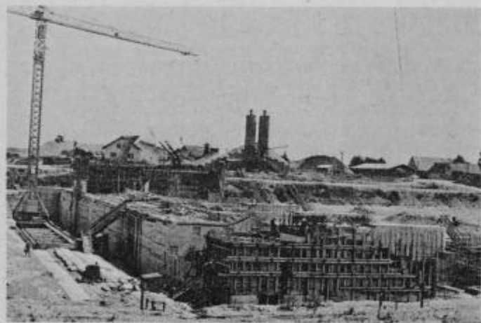
Temelji jezovne zgradbe pri Markovcih, potrebno bo 50 tisoč kubikov betona in 1.200 ton betonskega železa.
