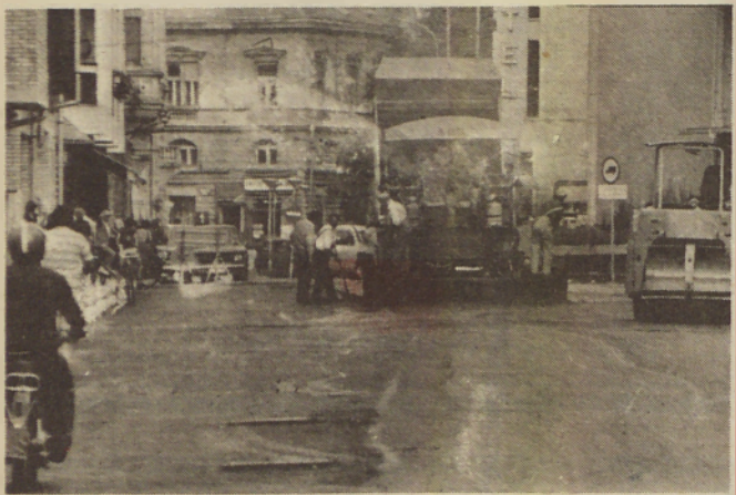
Takole so delavci Cestnega podjetja asfaltirali križišče v centru mesta.
