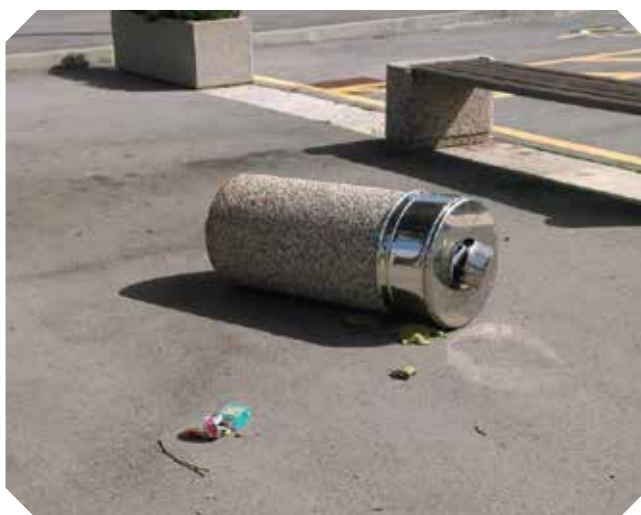
Primer počenega betonskega koša in poškodovane inox kape ter premaknjene klopi.
