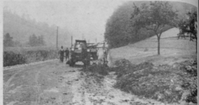
Trenutno tečejo dela pri urejanju jarkov ob že asfaltirani cesti na žetalski strani. (foto: M. Ozmeč)
