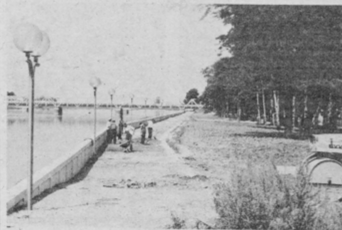
Priprava za asfaltiranje poti ob zaščitnem zidu ob Dravi
