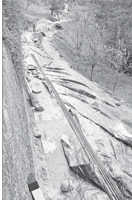
Dela na rekonstrukciji ceste potekajo intenzivno (Foto: SB)
