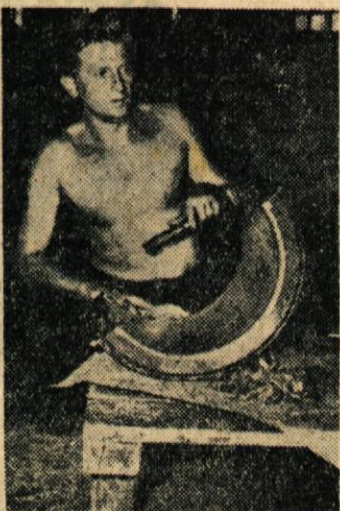
Tovariša Barbiča smo dobili pri brušenju dela ležaja glavne osi papirnega stroja; tu gre za stotinke milimetra...
