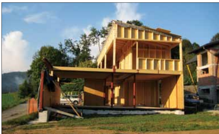
Lesena konstrukcija, nizkoenergijska hiša Lesno Brdo; foto: arhiv SKA
