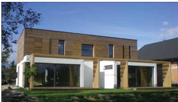
Lesena konstrukcija in drugi leseni elementi veliko prispevajo k prijetnem bivanju v nizkoenergijski hiši v Črni vasi; arhiv SKA
