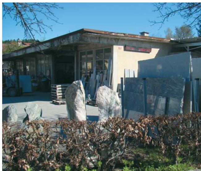
Pogled na delavnico Petra Oblaka s Tržaške ceste
