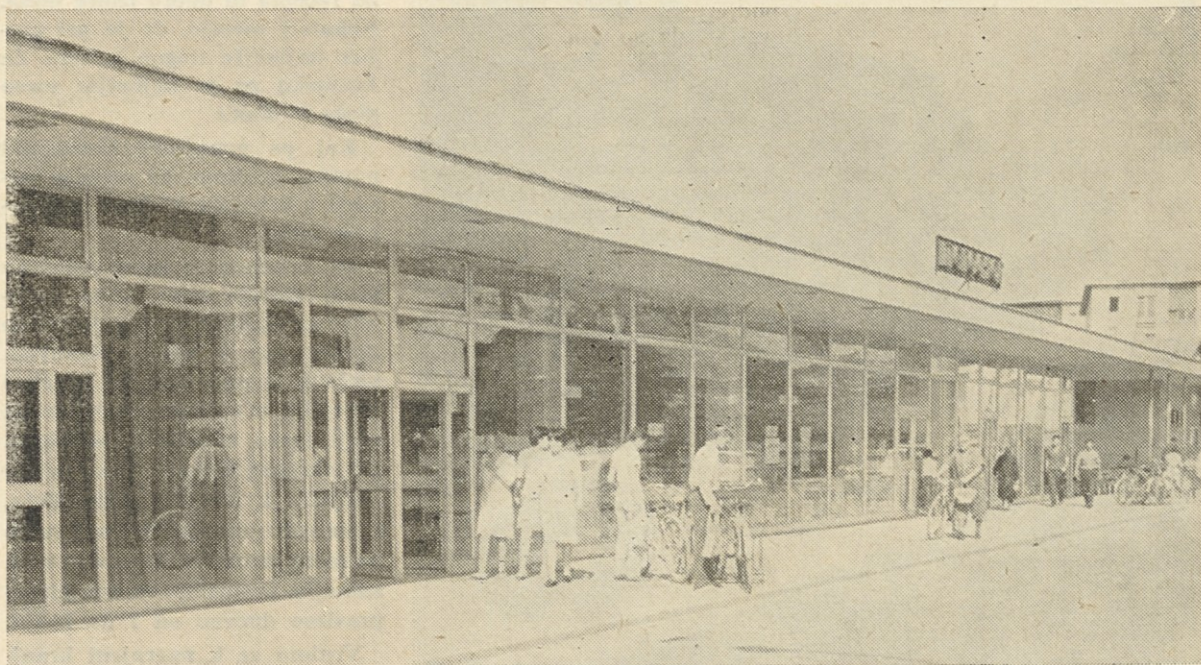
PE »Grmada« — Pogled na pročelje potrošniškega centra v središču Šiške (Tugomerjeva ulica)
