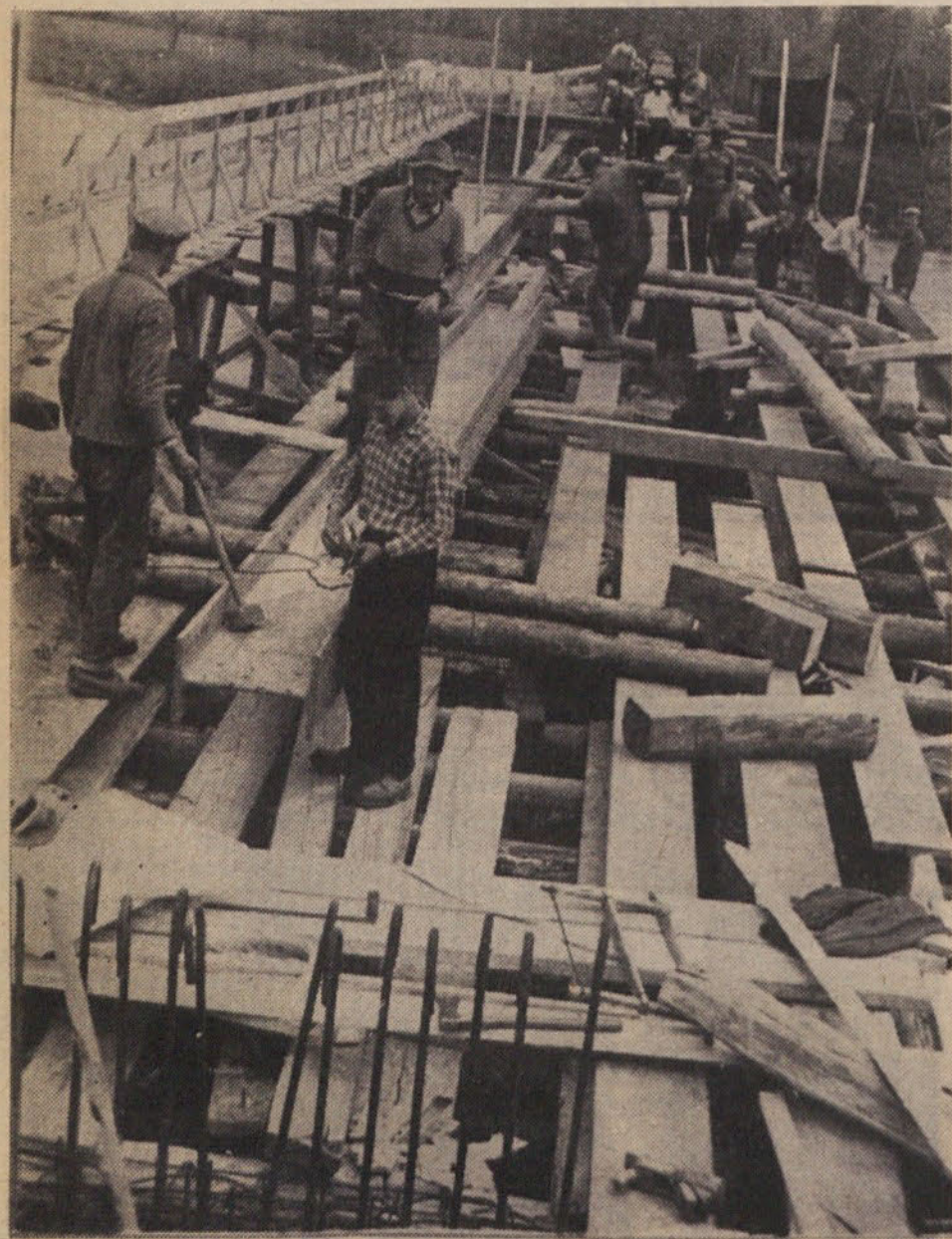
Gradnja mostu v Dolskem
