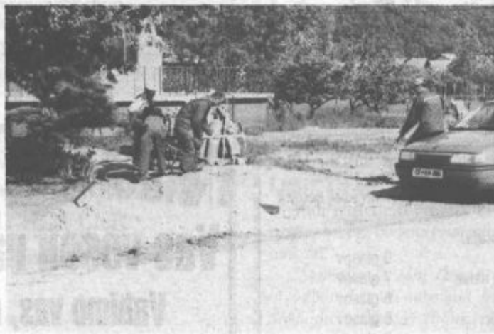
Dela pri več let načrtovani kanalizaciji bodo zaključili v teh dneh. Po opravljenem tehničnem prevzemu, bodo nanjo priključili sekundarne priključke
