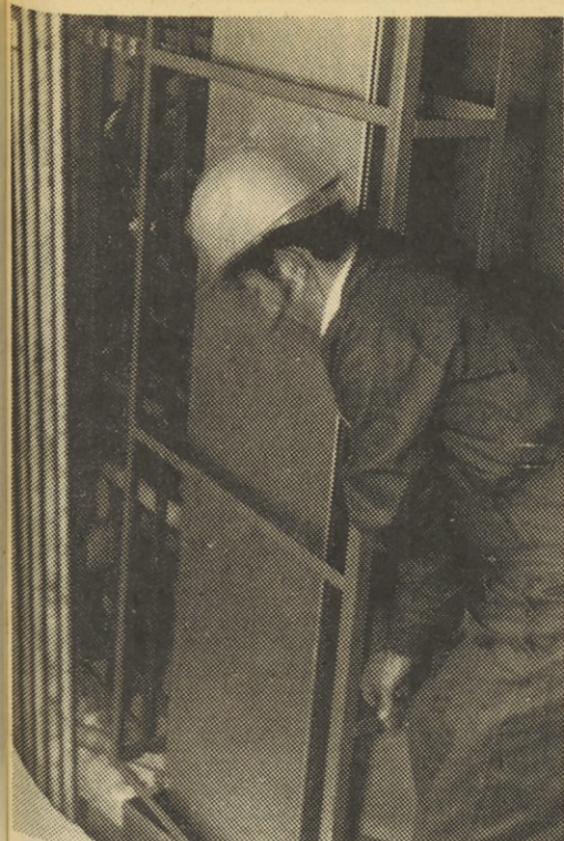
Instalacijsko steno sta postavila na svoje mesto dva monterja
