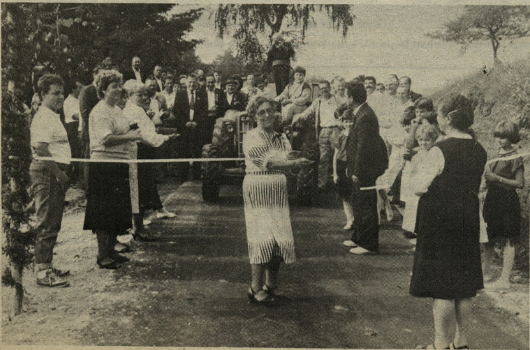
Novo cesto v Zg. Črnovi je odprla Anica Jovan, ki že vsa leta skrbi za vzdrževanje te ceste.
