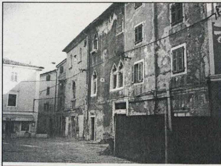
Il cantiere che viene e che va...
