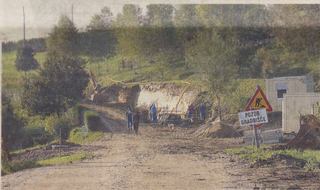
Sanacija plazu v Črešnjecih, ko bo končana, bodo asfaltirali še 500 metrov ceste.
