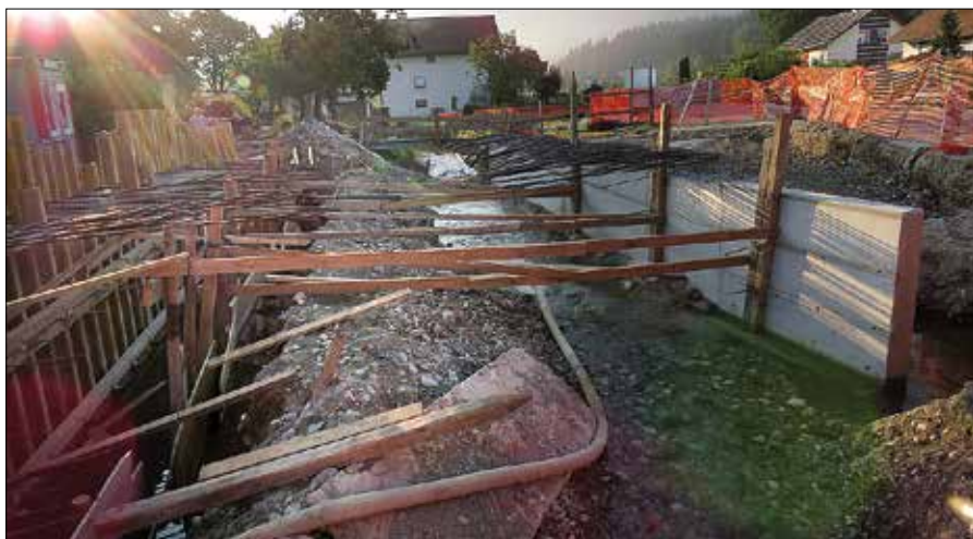
Most bo stal na dveh armiranobetonskih nosilcih. (Foto: IS)
