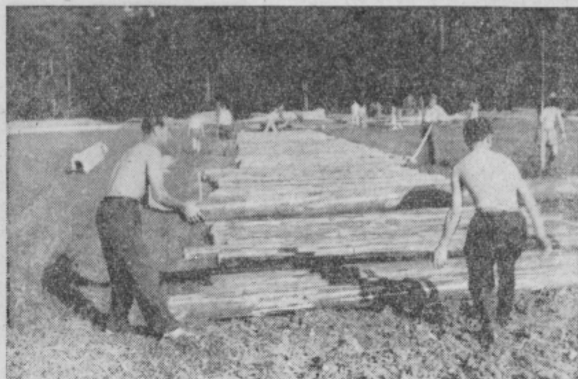
Od slavnostne tribune na Ostrožnem pa do glavne ceste grade prostovoljci 200 m dolgo leseno cesto. Namesto gramozu polagajo hlode ki jih bodo po končani slavnosti dvignili. Tako bo rodovitna zemlja nepoškodovana in sposobna za jesensko oranje.
