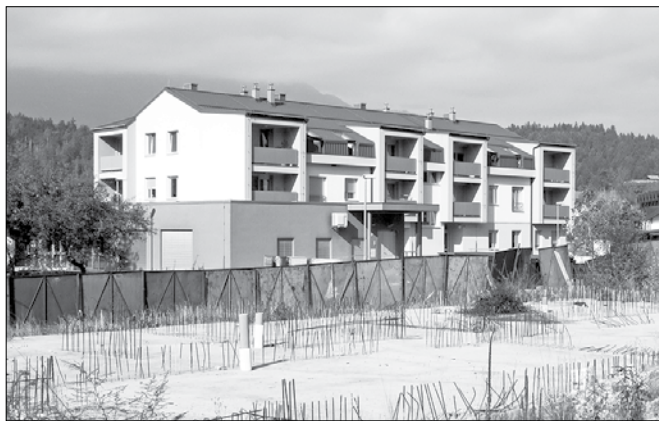
Temeljno ploščo, komunalno infrastrukturo in instalcijske vode so v podjetju Gradiatim izvedli pri gradnji prvega bloka. Z gradnjo drugega bodo začeli, ko bodo imeli dovolj zagotovil za odkup. (Foto: IS)
